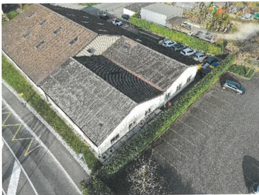
Vue aérienne du bâtiment
